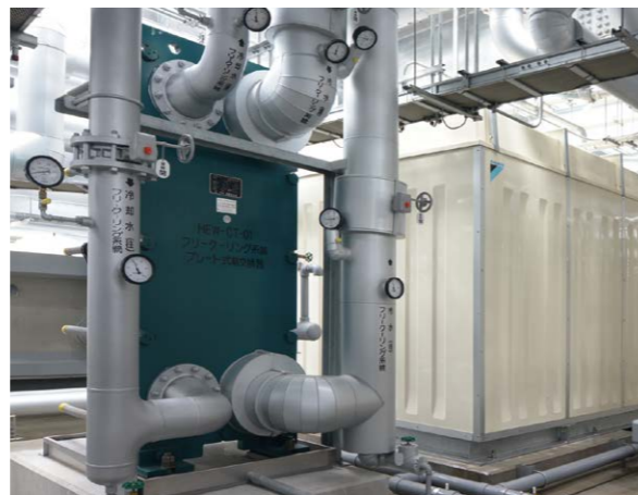
冷暖房、給湯、地域冷熱源供給受入れ、ビル蓄熱システムの冷却・加熱、未利用エネルギーからの熱回収
