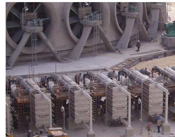
石油化学プラント、製鉄プラントなどの海水、河川水を使った集中冷却システム(CCS)
