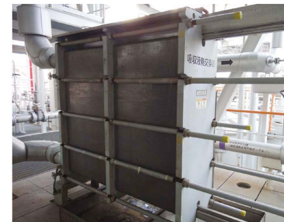
CO 2 回収プロセスで使われるアミン溶液の熱回収(ガasket型PHE)
