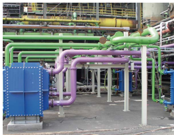
脱硫プラントの吸収液のリッチ/リーン溶液の熱回収(溶接型PHE)
